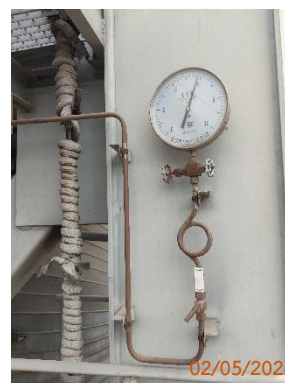
รูปที่ 2-55 Pressure gauge ของหม้อไอน้ำ
