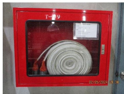
รูปที่ 2-50 ท่อดับเพลิงและตู้เก็บสายดับเพลิง
