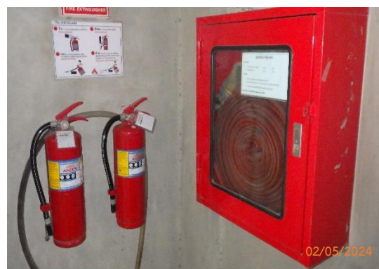
รูปที่ 2-49 อุปกรณ์เตือนภัยและดับเพลิง
