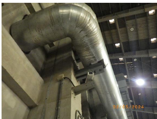
รูปที่ 2-47 ฉนวนกันความร้อนของระบบท่อไอน้ำ
