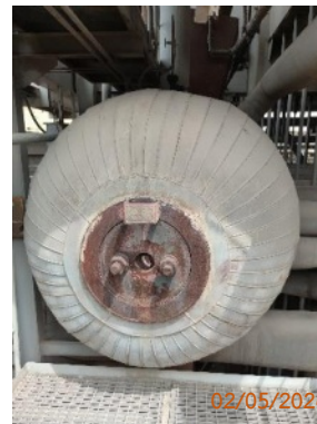
รูปที่ 2-53 Steam Drum ของหม้อไอน้ำ
