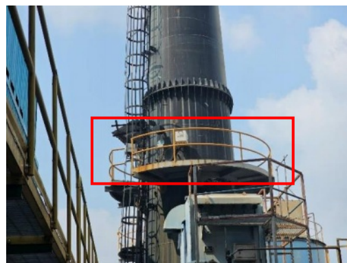
รูปที่ 2-14 ระบบ CEMS ที่ปล่องระบาย
