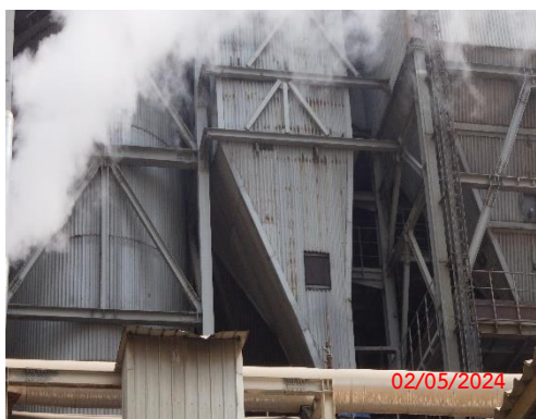
รูปที่ 2-9 ไซโลเก็บผงหินปูนแบบปิด
