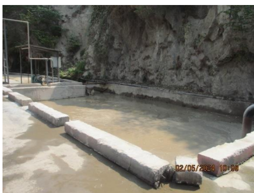
รูปที่ 2-68 บ่อน้ำขนาด 60 ลูกบาศก์เมตร ใต้หม้อผลิตไอน้ำ
